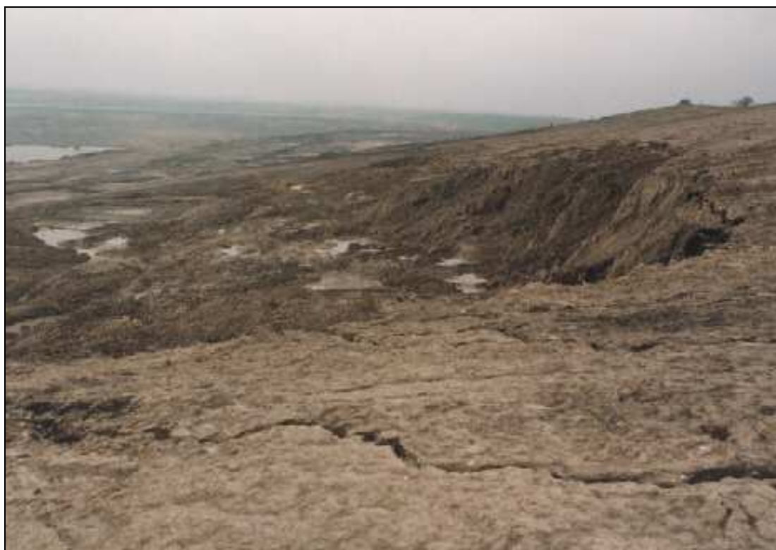
Fot. 5.2 Osuwisko w wyprofilowanej, górnej części zbocza (fot. KWB Konin)
