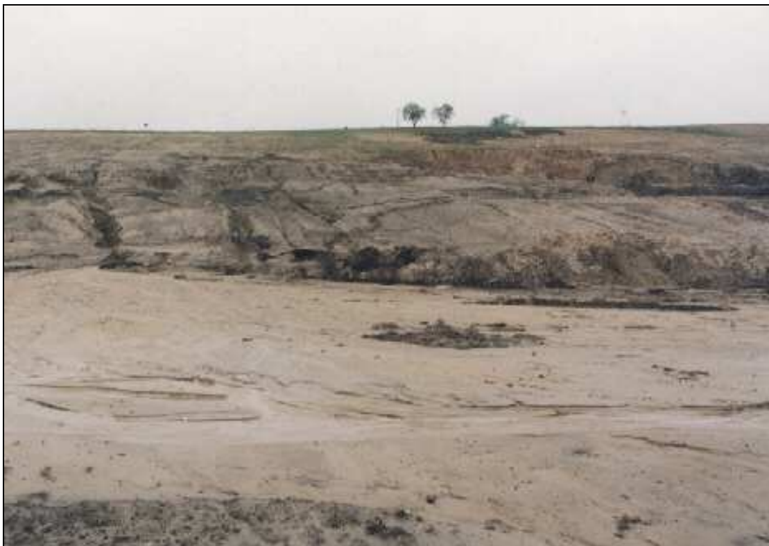
Fot. 5.1 Osuwisko powstałe na skutek widocznego upłynnienia fragmentu zbocza zwału po wyłączeniu bariery studni odwadniającej (fot. KWB Konin)
