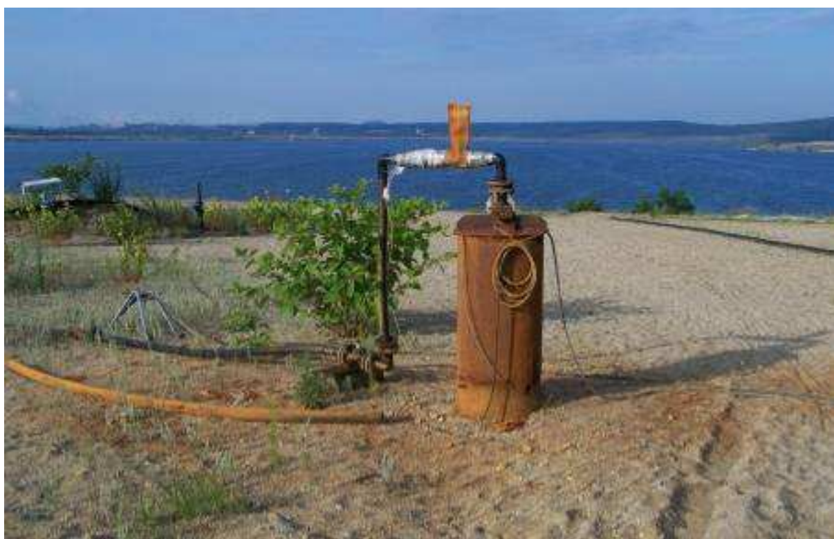
Fot. 5.8 Studnia odwadniająca zasilająca zbiornik Berzdorf (fot. K. Polak)
