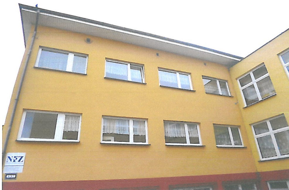
Foto.6. Wschodnia część, północnej ściany, południowego segmentu budynku. Fot. Przemysław Kubacki.
