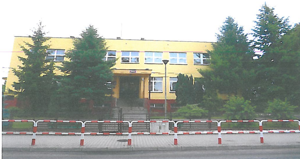
Foto.1. Widok budynku od strony północnej. Fot. Przemysław Kubacki.
