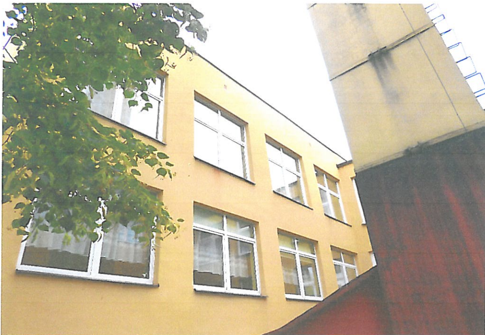
Foto.12. Zachodnia część, południowej ściany, północnego segmentu budynku. Fot. Przemysław Kubacki.
