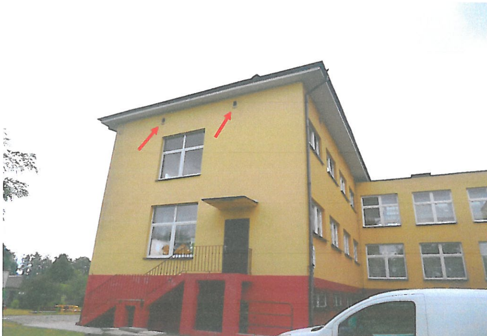
Foto.7. Wschodnia ściana południowego segmentu budynku z zaznaczonymi niezabezpieczonymi otworami wentylacyjnymi, siedliskiem kawki. Fot. Przemysław Kubacki.
