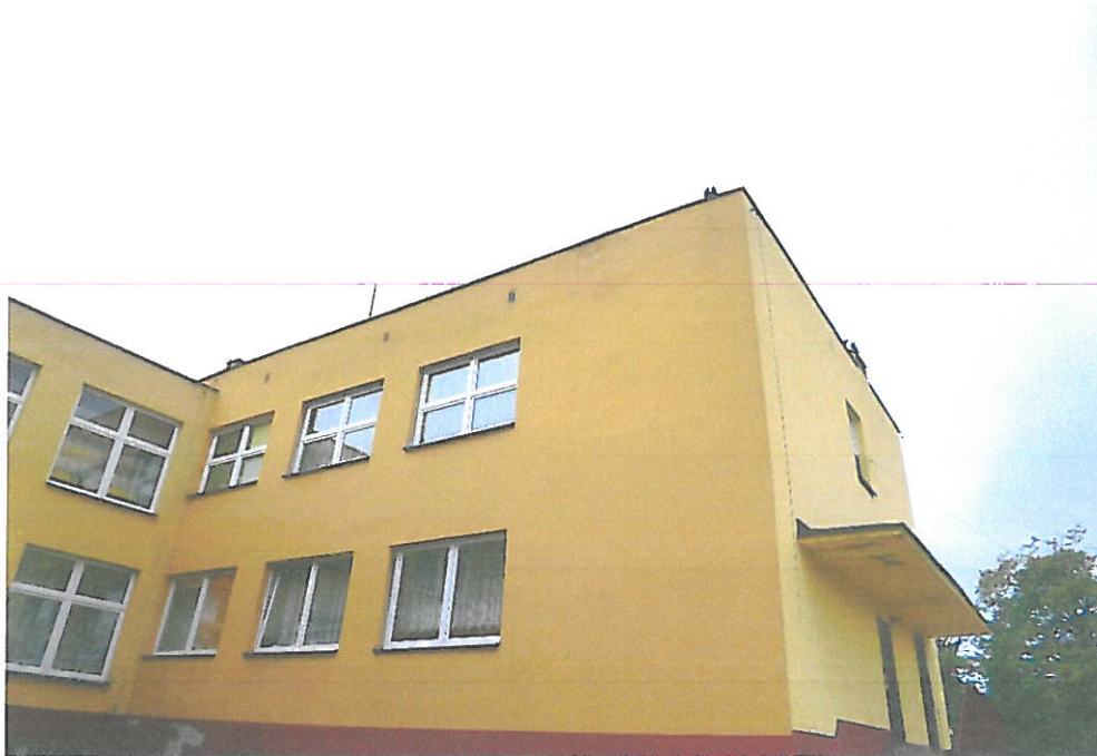
Foto.5. Wschodnia część, południowej ściany, północnego segmentu budynku. Fot. Przemysław Kubacki.
