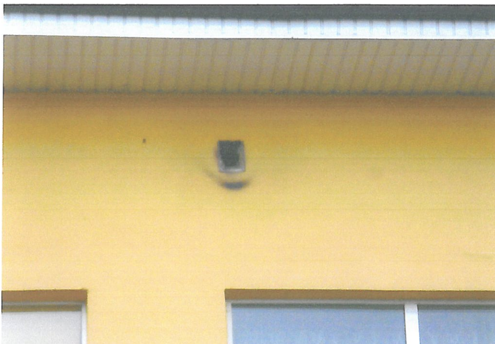
Foto.14. Niezabezpieczony otwór wentylacyjny stropodachu, siedlisko kawki. Fot. Przemysław Kubacki.
