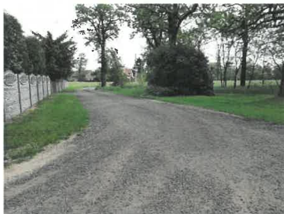
Utwardzenie drogi w m. Polichno
