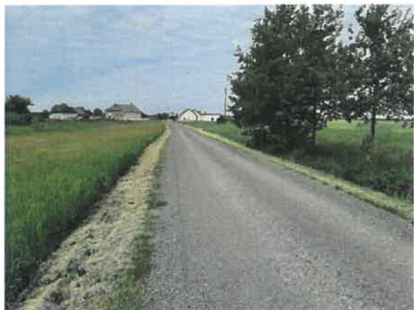
Utwardzenie drogi w m. Międzyzlesie
