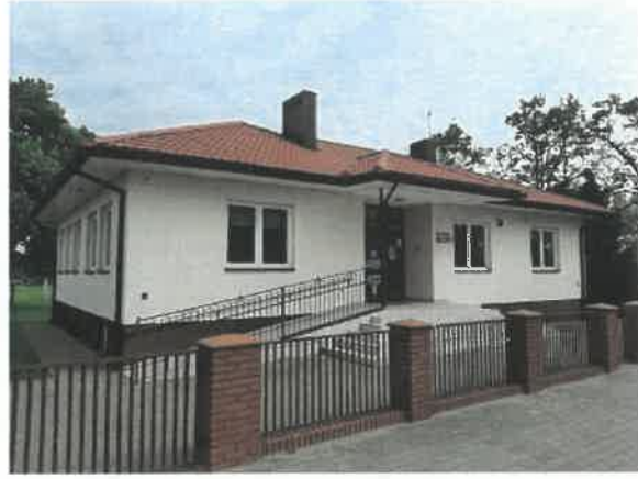
Budynek po szkole w Małoszynie
