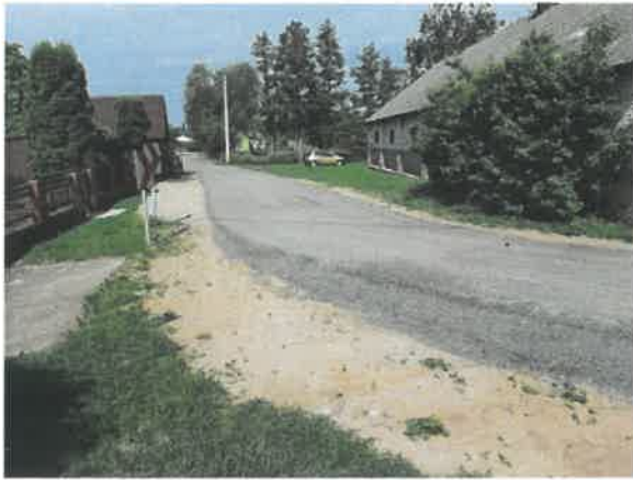
Budowa drogi w Chylinie
