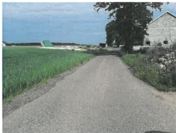
Utwardzenie drogi w m. Przyborów
