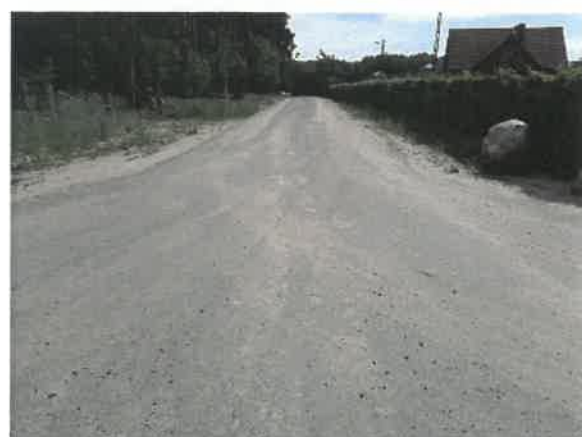
Budowa drogi Jabłonna Przyborów
