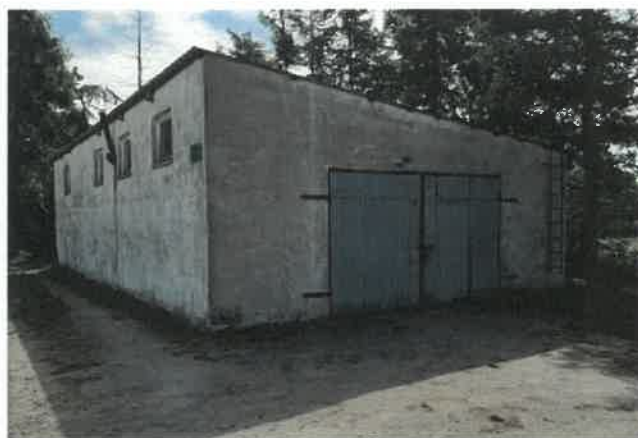
Budynek magazynowy Oczyszczalni Ścieków
