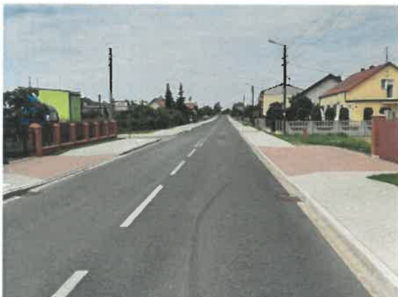
Przebudowa drogi w Russocicach
