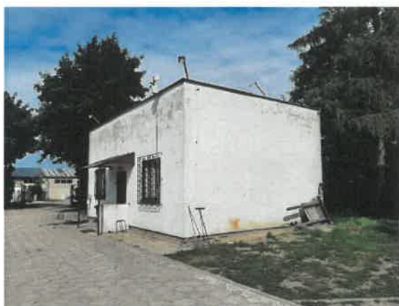
Budynek socjalny Oczyszczalni Ścieków
