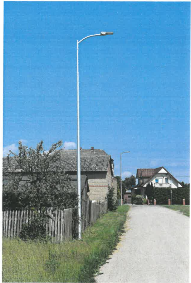
Oświetlenie uliczne – Wyszyna, ul. Bolesława Chrobrego
