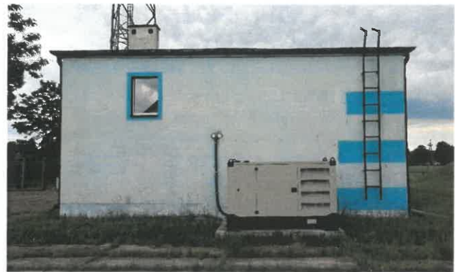
Remont Hydroforni w Russocicach
