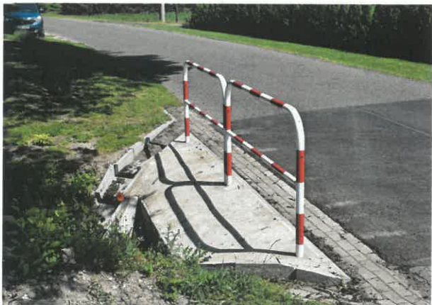
Przebudowa przepustu – Tarnowski Młyn
