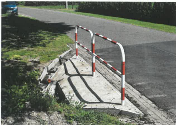
Przebudowa przepustu – Tarnowski Młyn
