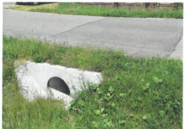
Przebudowa przepustu – Międzylesie
