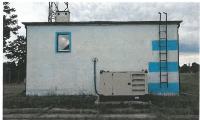
Remont Hydroforni w Russocicach
