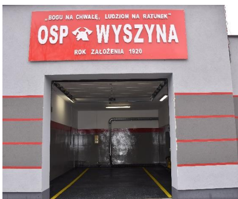
Termomodernizacja OSP Wyszyna
