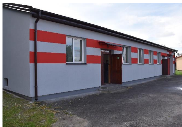
Termomodernizacja Sali spotkań w Małoszynie
